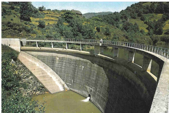
Barrage du Goul dans les années 1950 avant la construction de la tour centrale (Photo prêtée par M. Gérard NUGOU)
